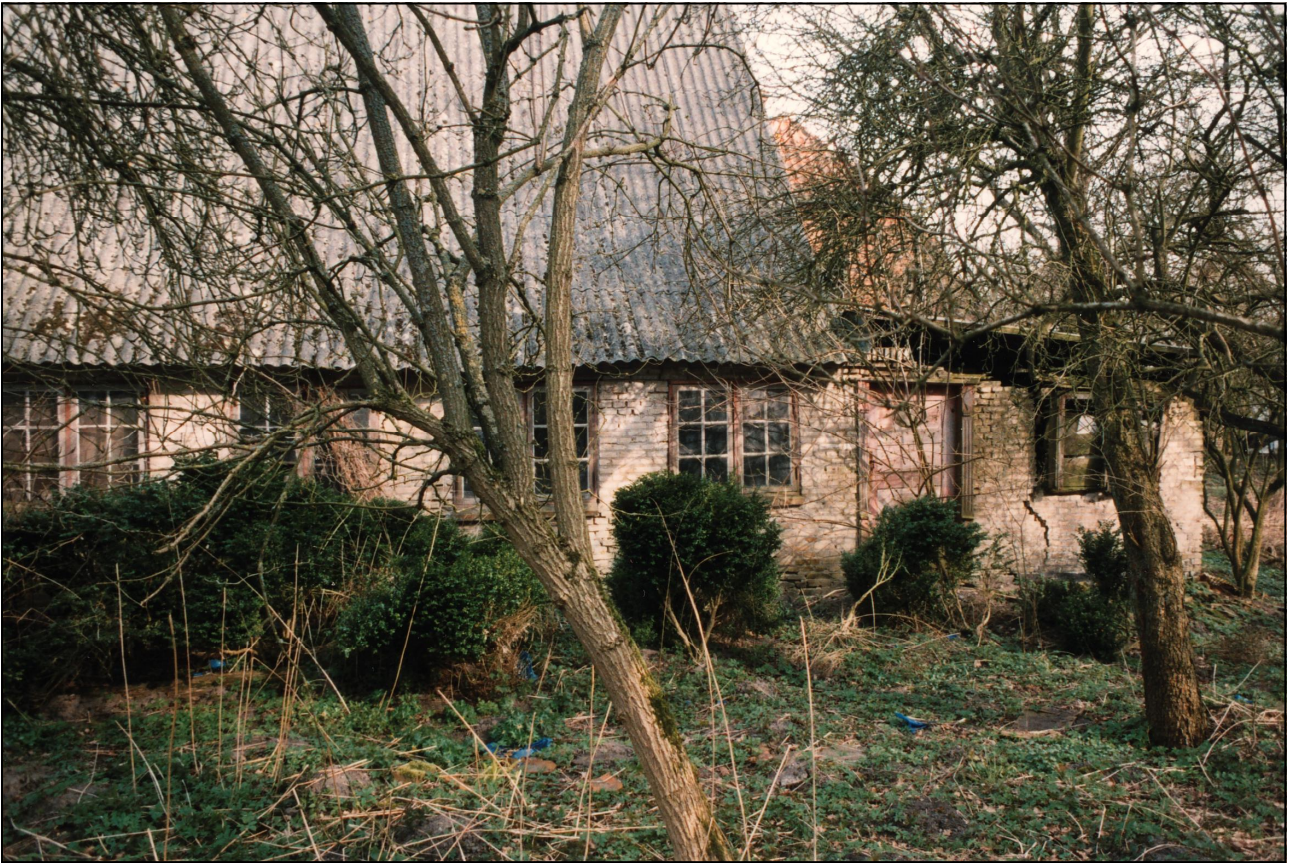
1995 - stuehusets sydside - med manglende tag over de tå østre fag.
