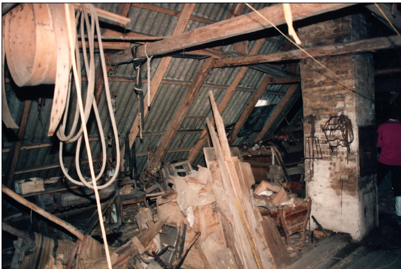
1995 - loftsrum over stuehusdelen - set mod sydvest.
