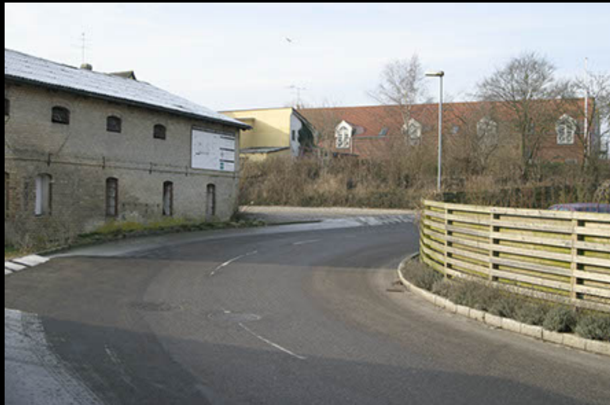
Storegade 39 2005 n fra Pottemagergade.JPG
