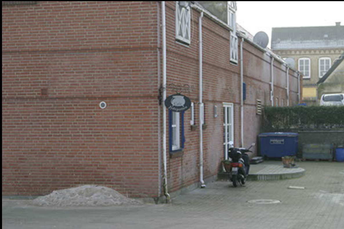
Storegade 27 2005 n fra Pottemagergade.JPG
